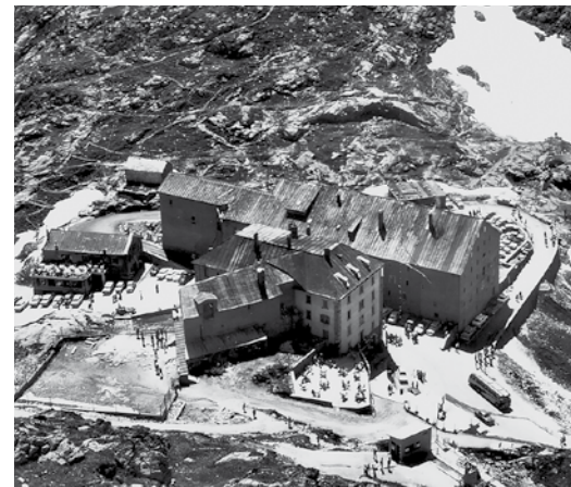
L'encastrement des bâtiments pour résister aux avalanches, carte postale d'A. Cretton, vers 1955 ©éditions du Gd-St-Bernard
