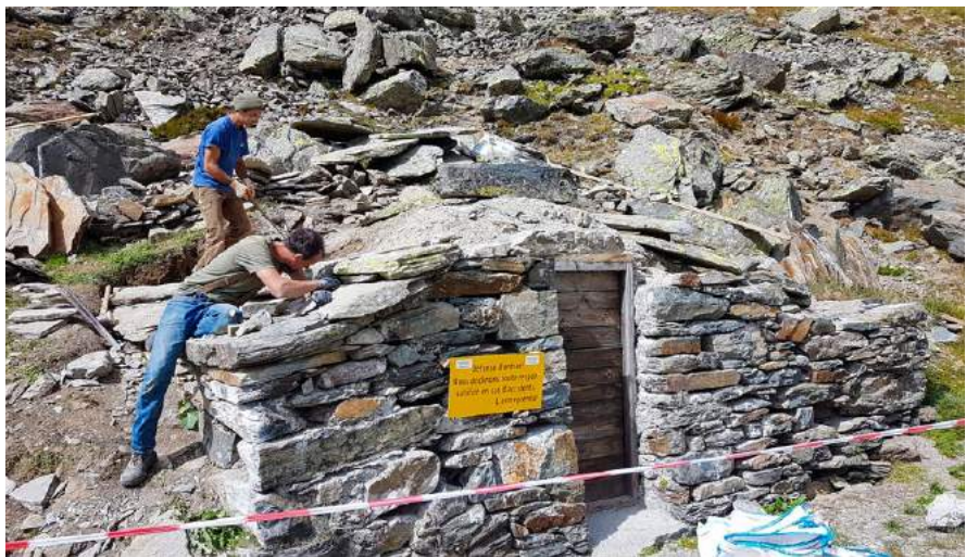
La cabane de la source en réfection.
