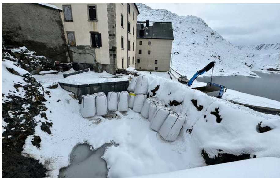
« Les dessous de la future terrasse, siège des nouvelles cuves » © Jean-René Pouget
